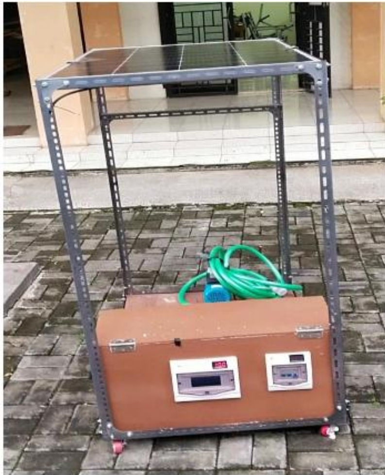
Gambar 1. Pompa air tenaga surya dengan switch remote control
