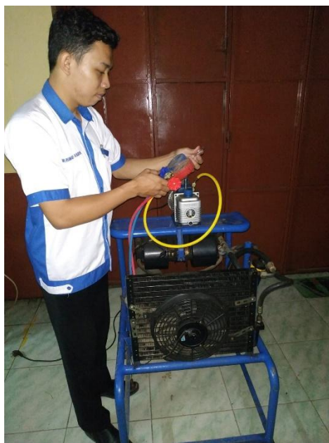
(Gambar sedang melakukan pengukuran menggunakan alat manifold gauge)
