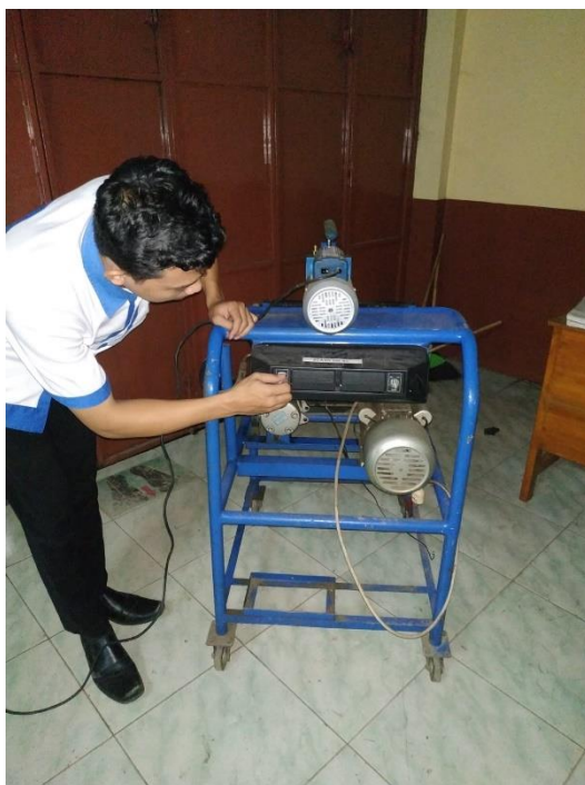
(Gambar sedang melakukan pengecekan blower AC)
