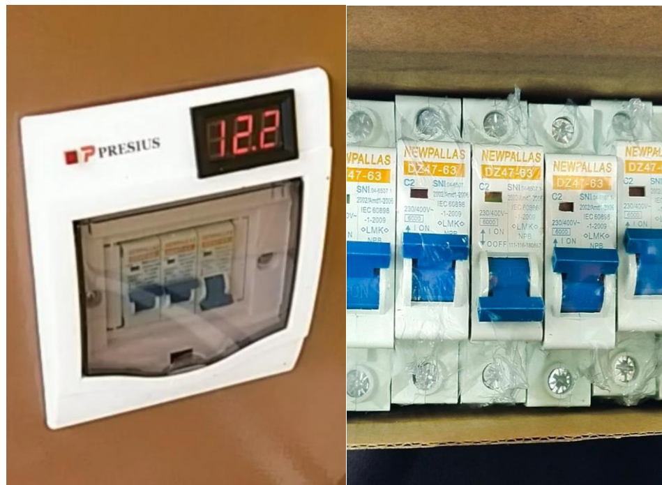
Gambar 4.10 Mini Circuit Breaker
