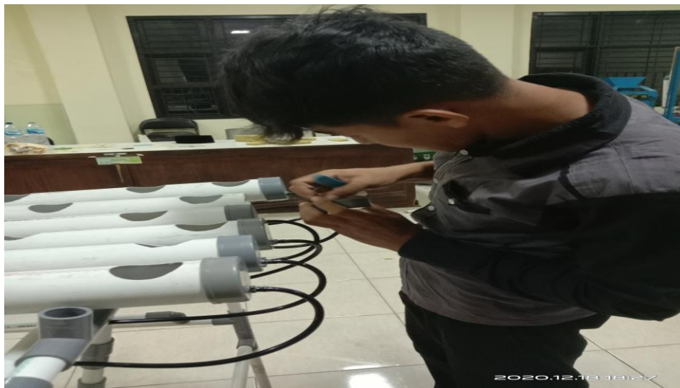
Gambar 4. Pengecekan selang input yang masih suka bocor
