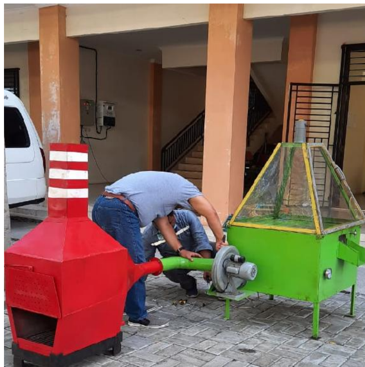
Gambar Proses Menginstall Mesin Pengering Biji Kopi
