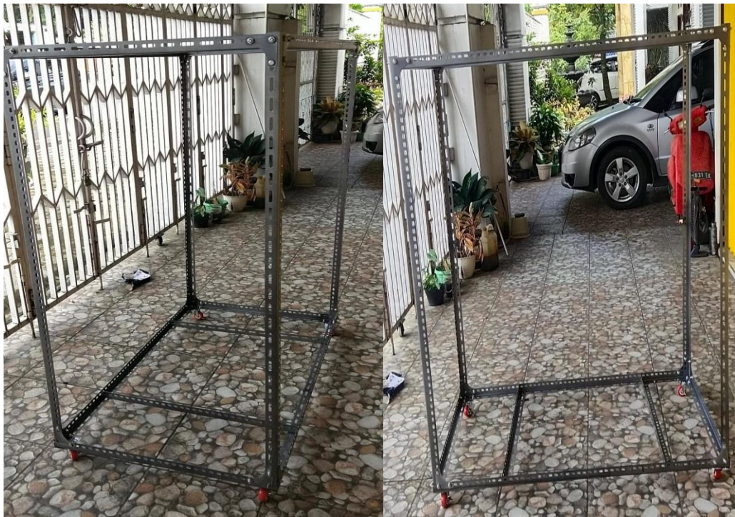
Gambar 4.2 Rangka pompa air tenaga surya
